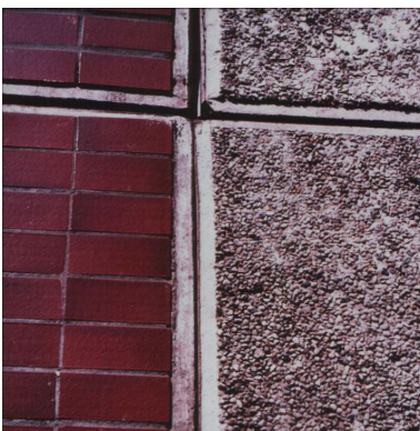
Fugen(schäden) im Fassaden- und Innenraumbereich
