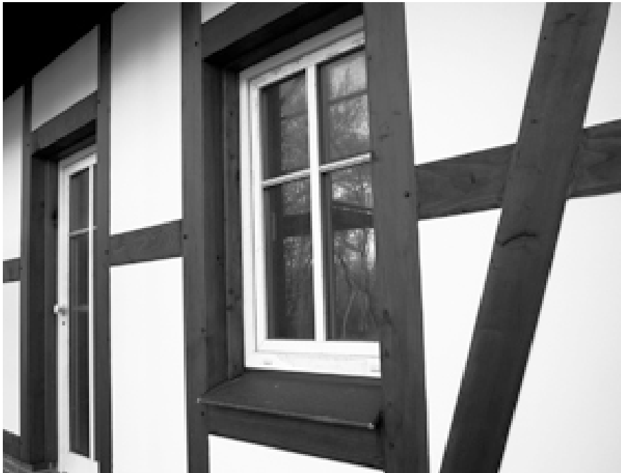
Beispiel: Wintergarten, Anschluss der Holzbalken zum geputzten Baukörper
